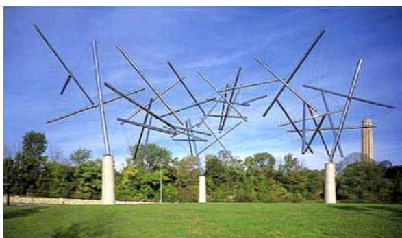
図-1 引張り材の海に浮かぶ圧縮材
